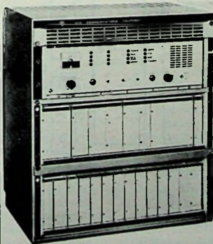
Afb. 1 L300 radioverbindingssystemen met een lage kanaalcapaciteit, past in de internationale standaardrekken.
